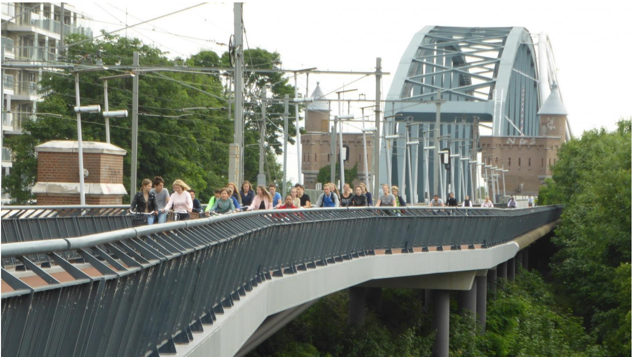
Figure 6 – Pont de Nimègue (Pays-Bas), et ses garde-corps inclinés
