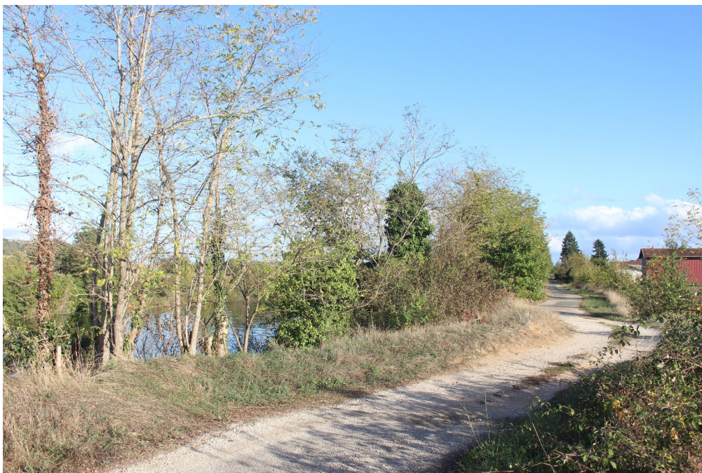
Figure 4 – Route coupée à la circulation automobile par l'effondrement des berges, le long du Lot entre Sainte-Livrade-sur-Lot et Casseneuil.
